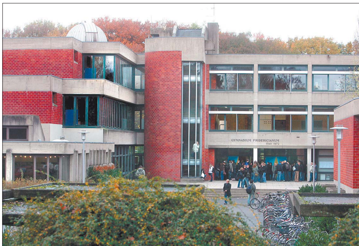
Sechs neue Unterrichtsräume sollen am Friedrichs-Gymnasium geschaffen werden. Das teilte Schulleiter Dr. Hans-Joachim Becker jetzt Dezernentin Jutta Decarli in einem Schreiben mit.
